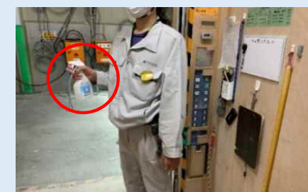
EVの操作盤等の消毒を徹底
