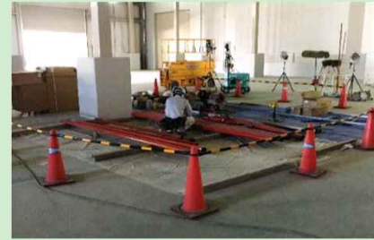
工事エリアの区画を設定して作業
