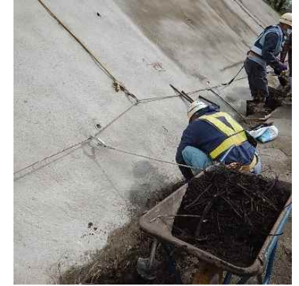
作業時なるべく離隔を確保
